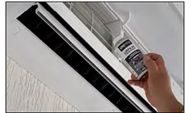
Direcione o spray para a parte frontal do ar condicionado. Também pode ser aplicado no filtro.
